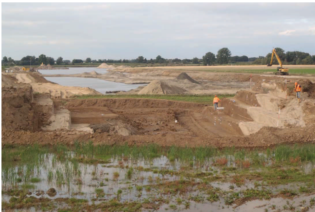
Afb. 3.4 Coupe door de Empelsedijk met op de achtergrond in het noorden het nieuwe Máximakanaal in de Koornwaard. (Foto J. Flamman, Vestigia).
