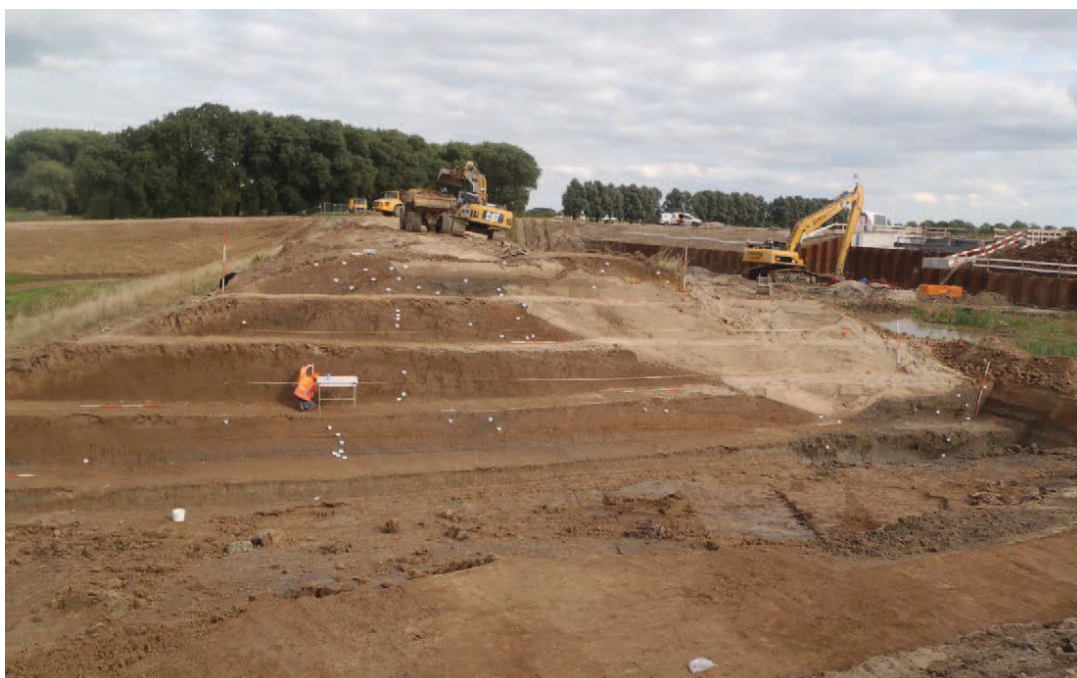
Afb. 3.9 Documentatie van het profiel van de Empelsedijk met rechts op de achtergrond de in aanbouw zijnde sluis Empel. (Foto richting oost).
