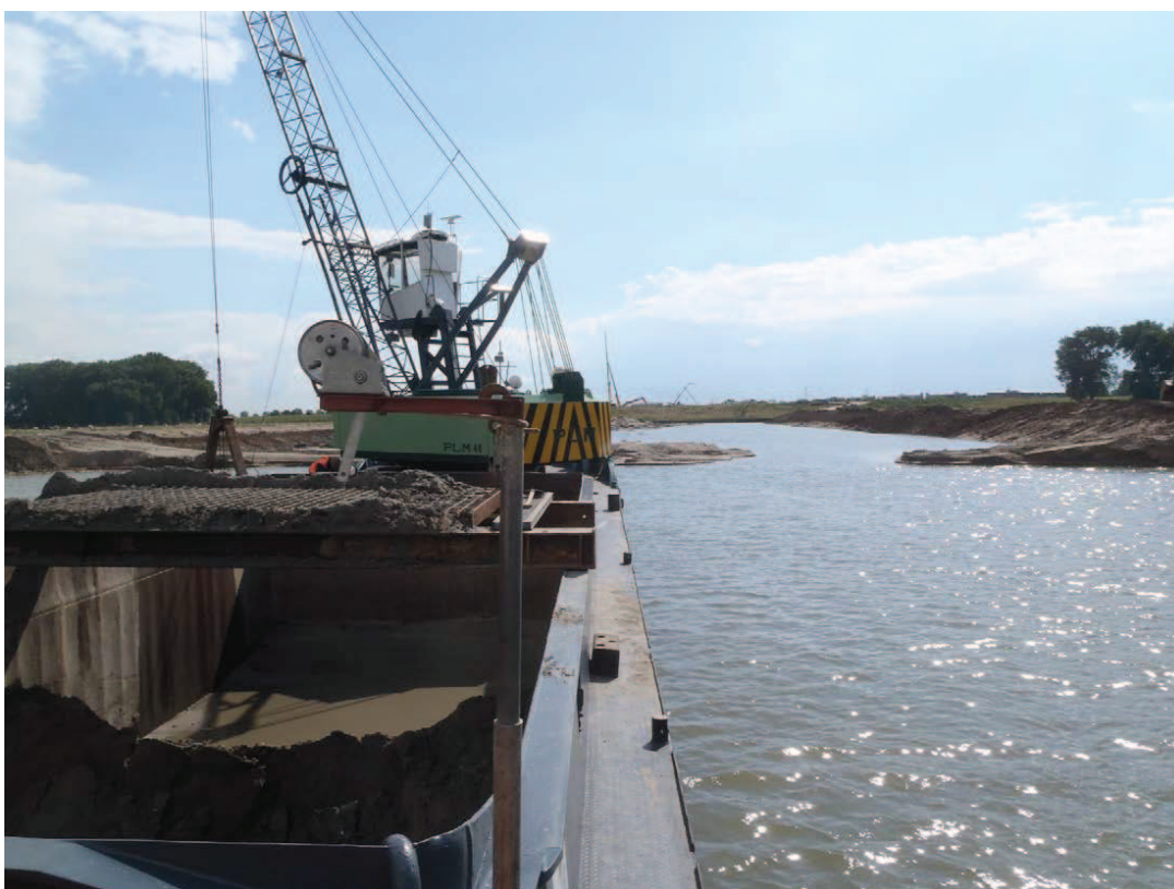
Afb. 3.1 Kraanschip met zeefrooster met op de achtergrond in het zuiden de Empelsedijk.
